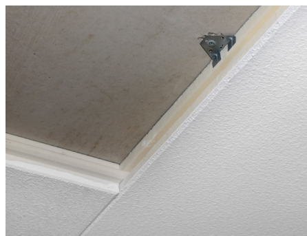
Kellerdeckendämmung unter Betondecke
