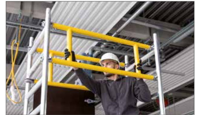
Montage im absturzesicherten Bereich dank 3-T-Methode
