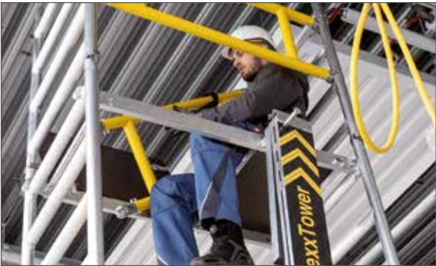
Obere Geländer und Bordbretter montieren
