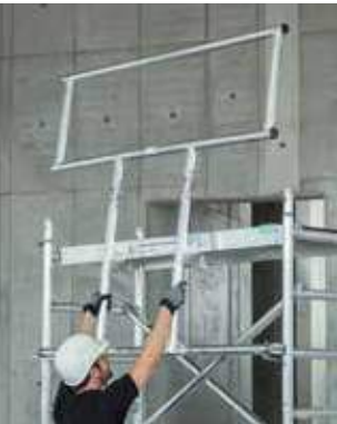
Vor dem Besteigen der ersten Plattform wird der Zusatzrahmen mühelos vom Boden aus eingesteckt.
