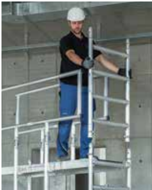
Gesichert durch das „vorlaufende Geländer“, kann die Plattform nun gefahrlos betreten und der weitere Gerüstaufbau fortgesetzt werden. Das Montagesicherungsgeländer wird für folgende Plattformen wieder „vorlaufend“ eingesteckt.
