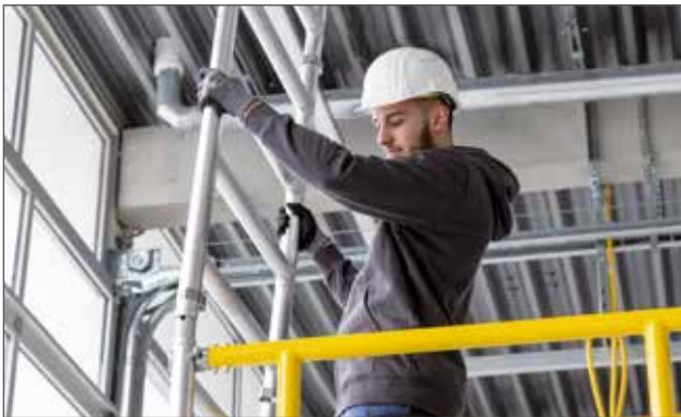
Weitere Aufsteckrahmen einsetzen
