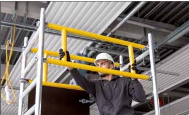
Montage im absturzesicherten Bereich dank 3-T-Methode
