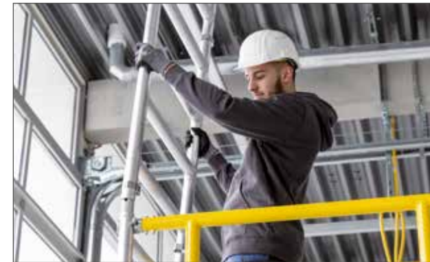
Weitere Aufsteckrahmen einsetzen
