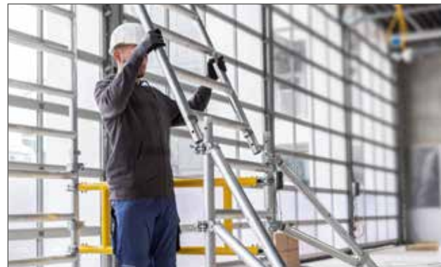
Intuitive Steckverbindungen mit Federclips
