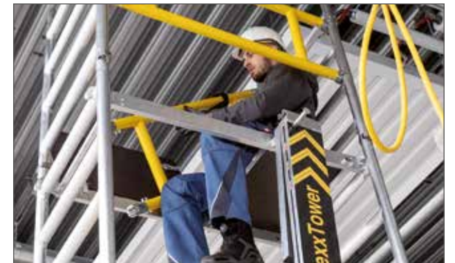
Obere Geländer und Bordbretter montieren
