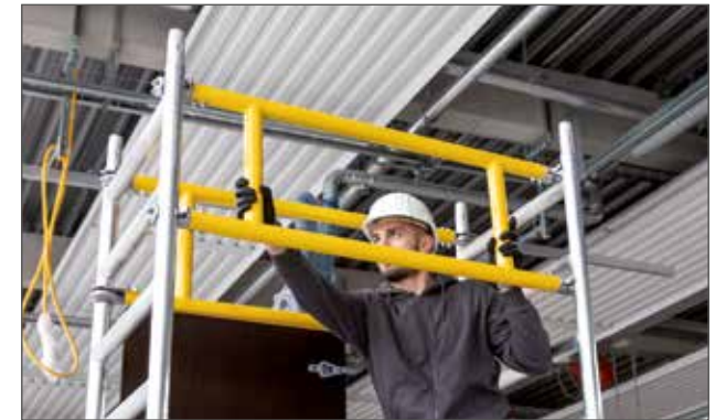
Montage im absturzesicherten Bereich dank 3-T-Methode
